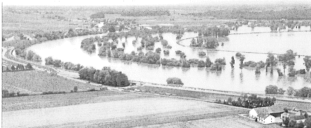
Der Deich bei Ruckasing hat beim Hochwasser glücklicherweise gehalten. Im Zuge des Hochwasser-Schutzkonzepts soll hier das Bollwerk erhöht werden. – Foto: Schwarzbözl
